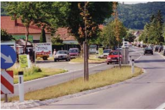
Ortseinfahrten wurden verkehrssicher umgestaltet, Beispiel Donnerskirchen
